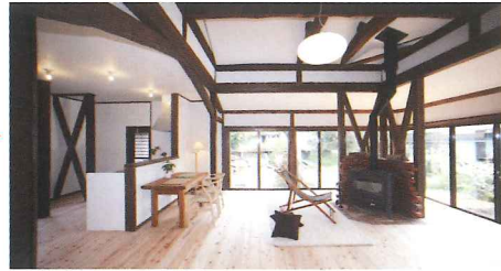
全面リフォームの施工事例。構造補強を施し、セルロースファイバーによる断熱改修も実施。しっかりとした木構造を表して、古民家ならではの風合いを生かしたプランです。
